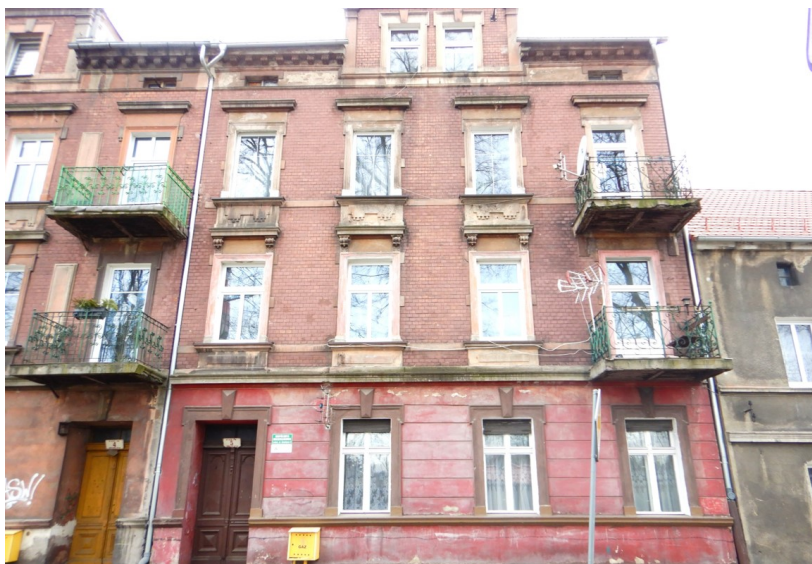
Ogólny widok budynku
